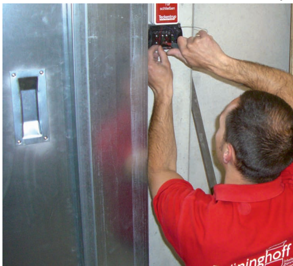
Service-Monteur von Brüninghoff
